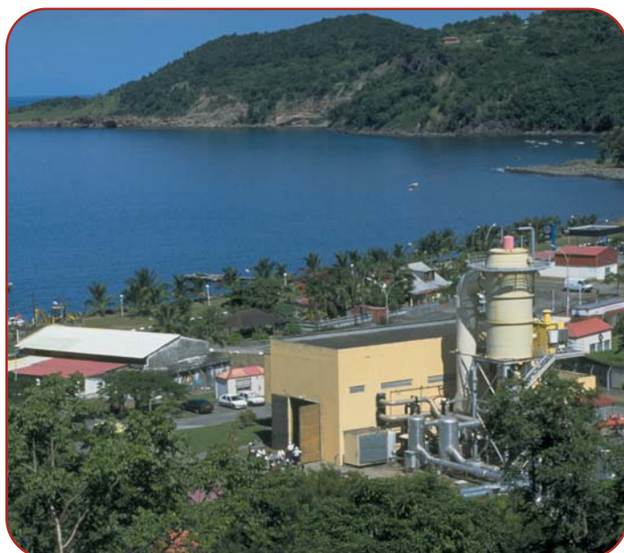
Centrale géothermique de Bouillante (Guadeloupe)
