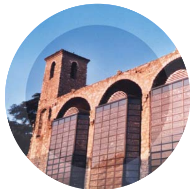
Photovoltaïque raccordé au réseau
