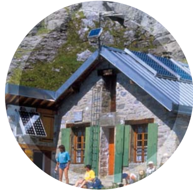
Photovoltaïque en site isolé
